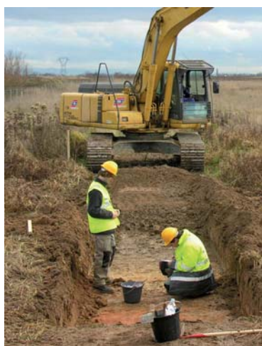
Entzheim : les archéologues guident la pelle mécanique
