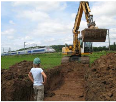
Creusement des tranchées de diagnostic, Wilwisheim
