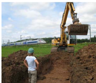
Creusement des tranchées de diagnostic, Wilwisheim
